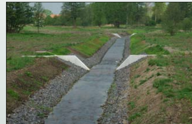
Fot. 16. Drastyczna zmiana charakteru cieków - zniszczenie obudowy roślinnej, likwidacja meandrów i sztuczne formowanie brzegów sprzyja zadomawianiu się roślin synantropijnych, w tym także gatunków obcych geograficznie, na zdjęciu rzeka Bielawka w Dłuzynie Górnej (Fot. Z. Dajdok)
