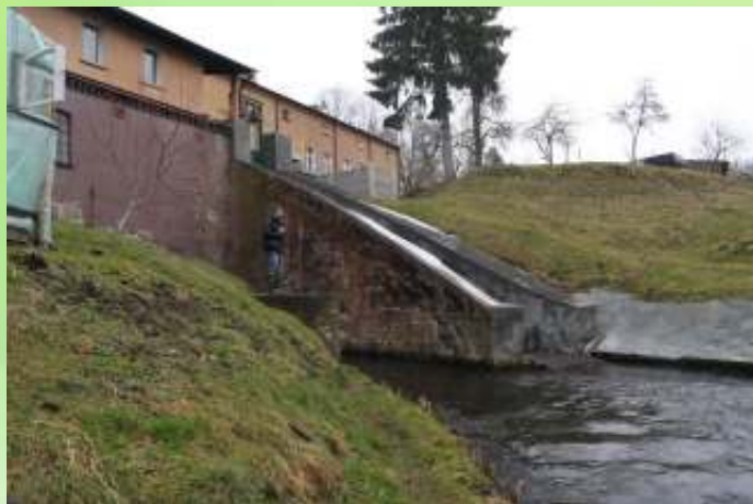
Cały przepływ kierowany jest na turbiny elektrowni w Skarszewie o mocy 188 kW, spad 7,8 m
