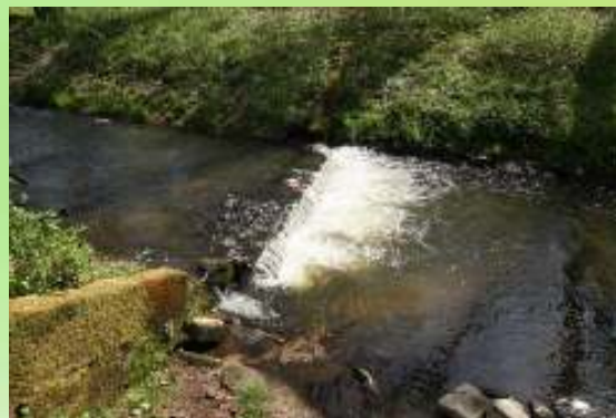
Rozmyty stopień betonowy dna w Krępie w km 1 + 983
