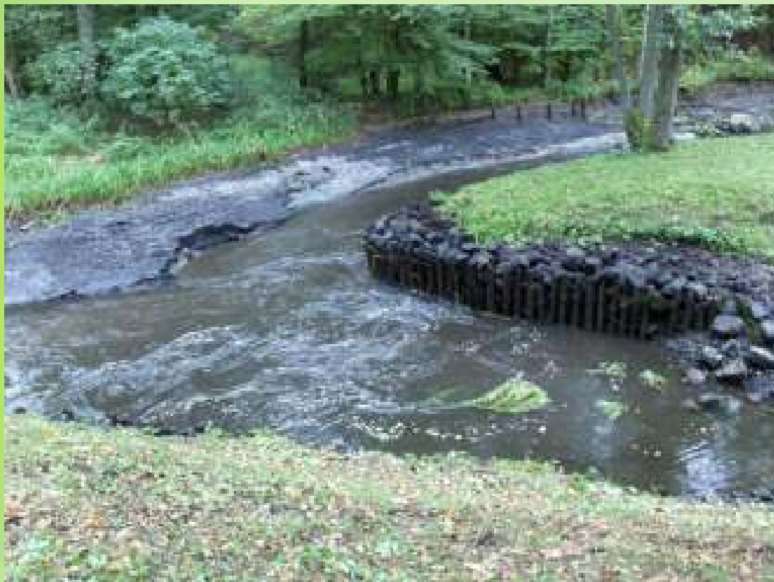
Remont MEW na Skotawie (największym dopływie Słupi) – gwałtowne odsłonięcie dna w zasięgu cofki.....
