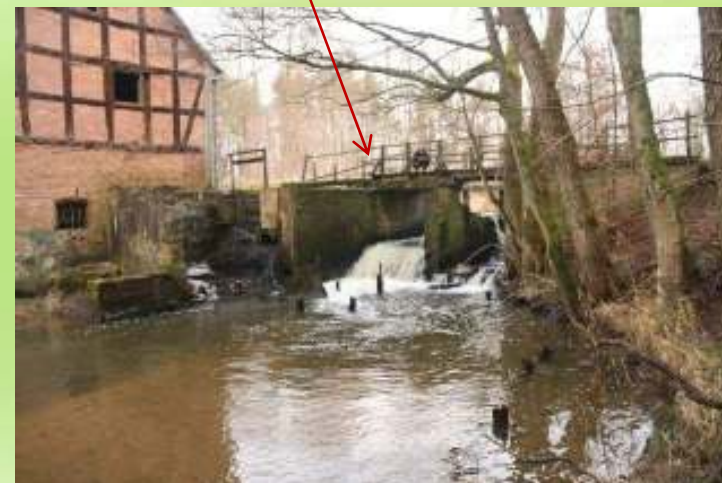
Jaz piętrzący obok starego młyna na Gnilnej w Bydlinie w km 0 + 264 - kres wędrówek ryb anadromicznych w rzece
