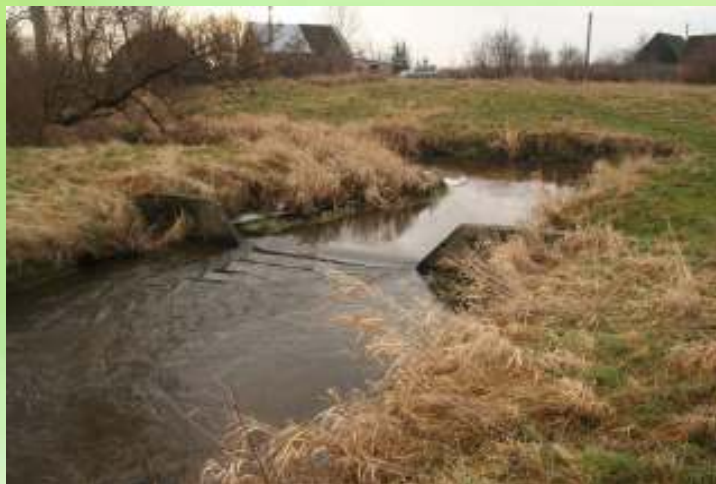
Stopień betonowy w km 3 + 320 nie stanowi bariery w wędrówkach ryb
