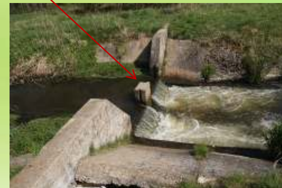
Stopień betonowy w Krępie w km 1 + 589 - wysokość piętrzenia około 40 cm
