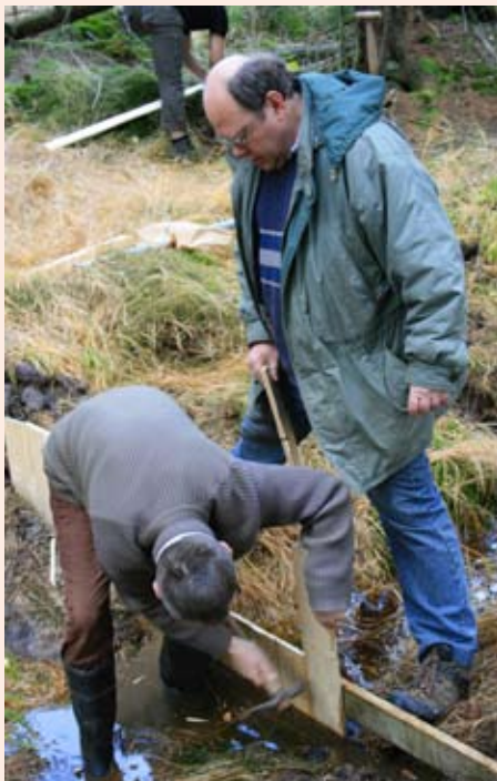
Instalacja urządzenia do mierzenia odpływu wody z torfowiska
