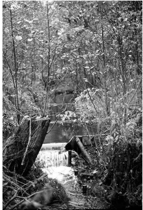
Proste piętrzenie na niewielkim cieku w Nadleśnictwie Rzepin
