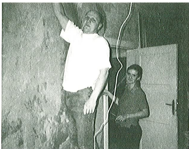
Wiosną remontowaliśmy nasze biuro w Świebodzinie, jak widać - własnymi rękami.
