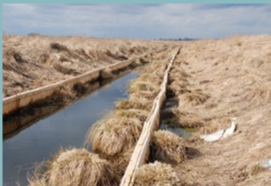
Ścianka zapobiegająca drenażowi torfowiska kopułowego na torfowisku koło Zamościa Fot. Robert Stańko
