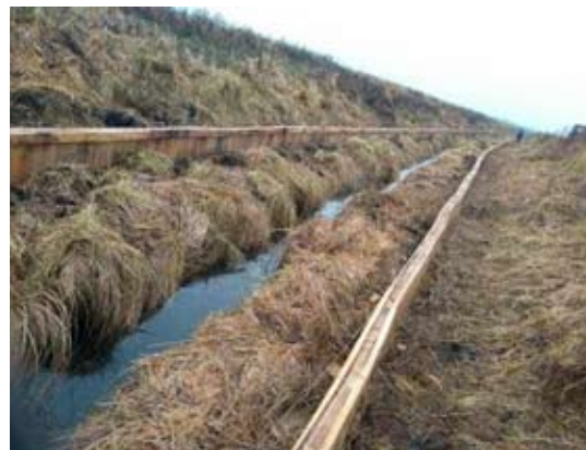
Ścianka prawie na ukończeniu.
