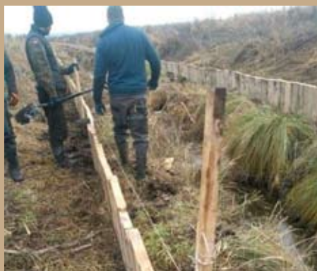
Fot. 1. Wytyczenie linii przebiegu ścianki.
