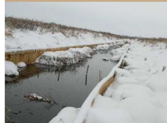
Finalny efekt ścianki przeciwfiltracyjnej przy podwyższonym stanie wody w rzece. Fot. W. Spychała
