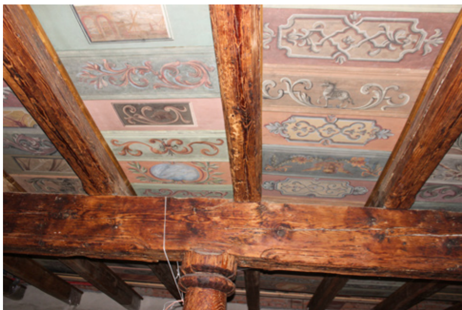
Polichromie po konserwacji w przestrzeni sufitu sali zrębowej
