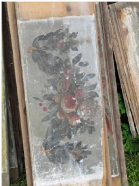
Zabytkowe deski stropowe przed konserwacją
