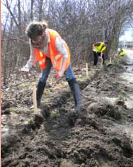
Budowa płotku na Kajce w Poznaniu.
