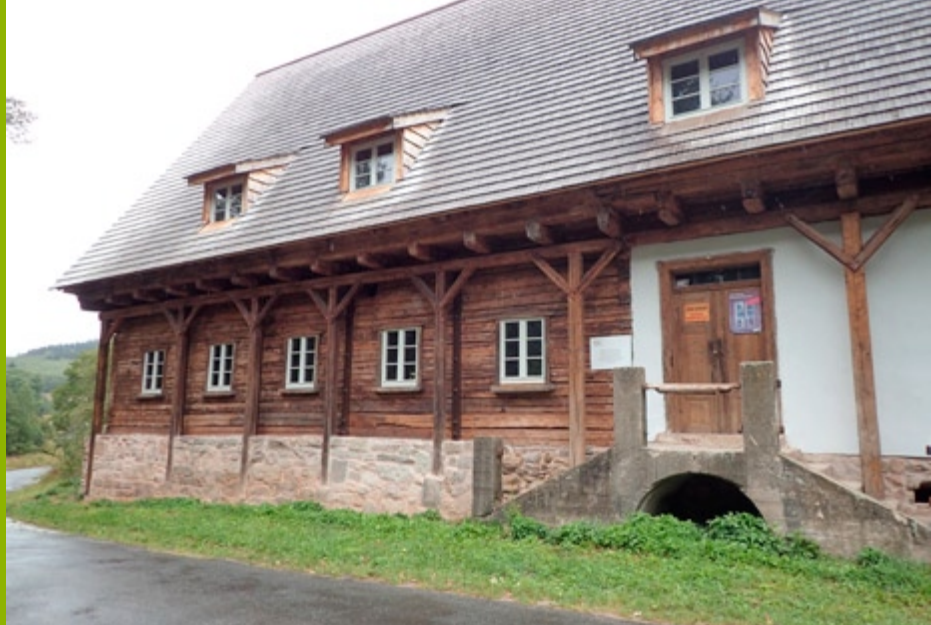
Odnowiony front zabytkowego budynku remontowanej Stacji Klubu w Uniemyślu. Fot. Andrzej Jermaczek
