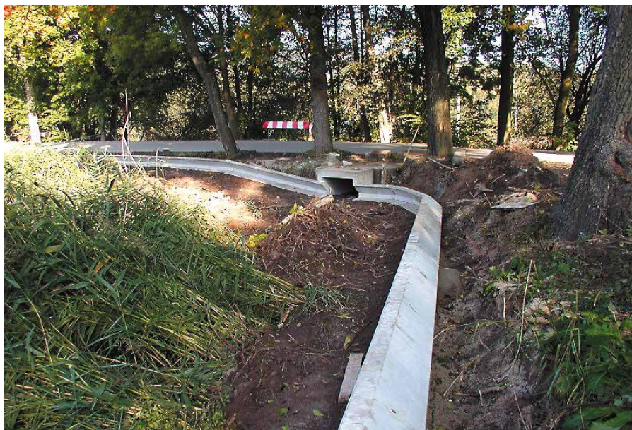
Fot. 59. Pierwszy w Polsce system tuneli i ogrodzeń dla płazów przechodzących przez drogi (Park Narodowy Gór Stołowych, fot. Krzysztof Baldy)
