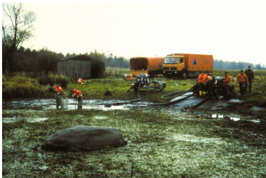
Fot. 51. Wypompowywanie wody w celu usunięcia ryb i szlamu ze stawu (fot. Finn Hansen)
