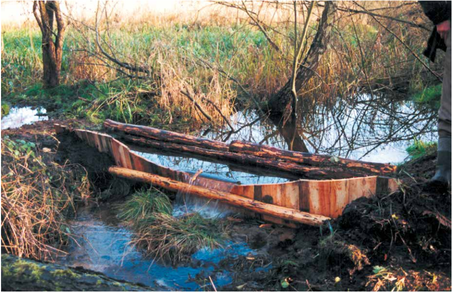
Fot. 27. Zastawka piętrząca wodę - ważny element aktywnej ochrony gatunku (fot. Marek Maciantowicz)
