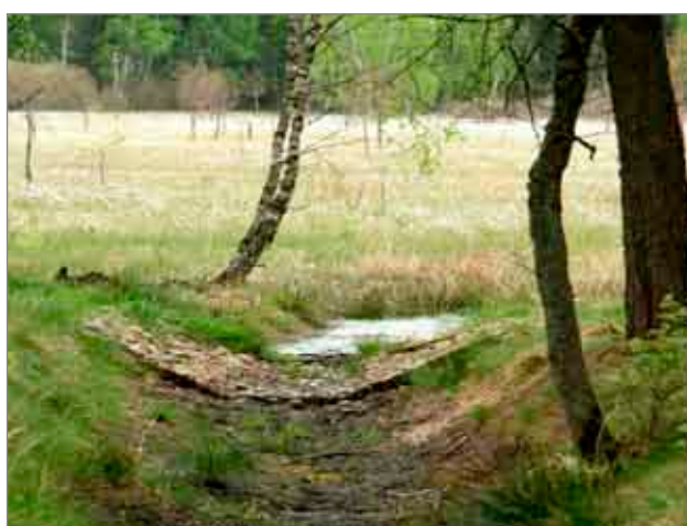
Zbudowany przez nadleśnictwo Głusko próg na odpływie z Torfowiska Pięć-Sześć. Fot. P. Pawlaczyk
