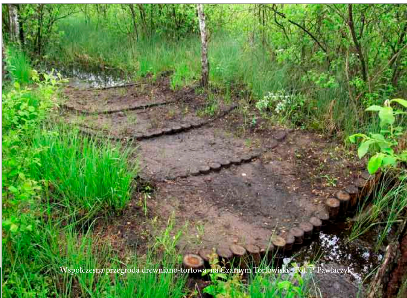
Zbudowany przez nadleśnictwo Głusko próg na odpływie z Torfowiska Pięć-Sześć. Fot. P. Pawlaczyk
