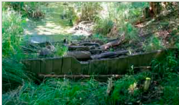
Przegroda zbudowana pod koniec XX w. na rowie odwadniającym Torfowisko Osowiec, po 15 latach od jej wykonania.
