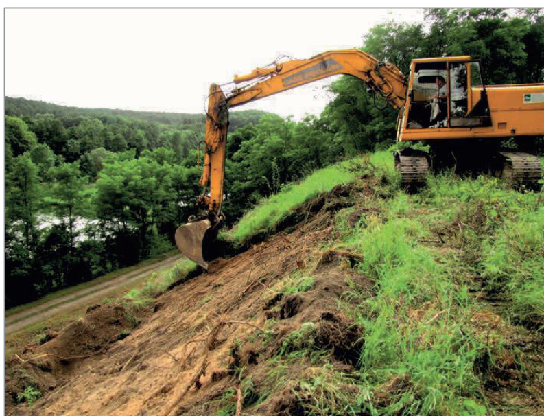
Fot.71. Zdzieranie wierzchniej warstwy gleby w podobszarze Trutwiniec (obszar Dolna Odra) (fot. K. Barańska)
