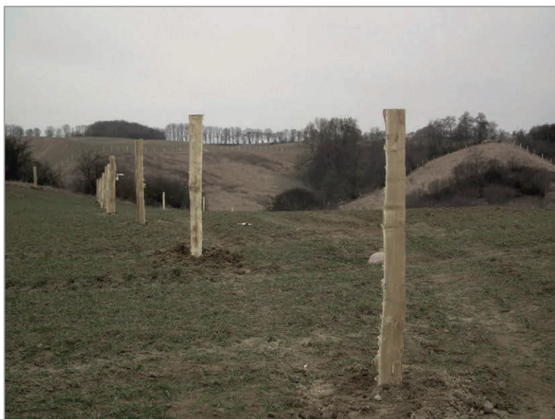
Fot.81. Stawianie ogrodzeń na powierzchniach przeznaczonych do wypasu (fot. P. Pluciński)
