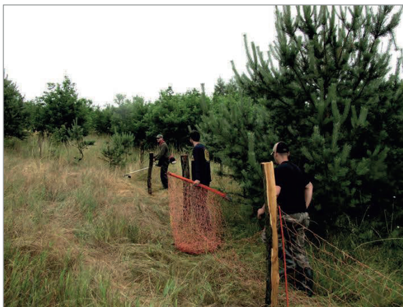
Fot. 80. Montowanie ogrodzenia na powierzchni przeznaczonej do wypasu (fot. K. Barańska)
