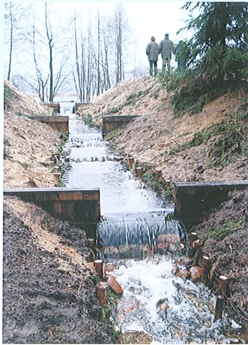
Różne typy zastawek na torfowisku na rowach melioracyjnych. Fot. R. Stańko.
