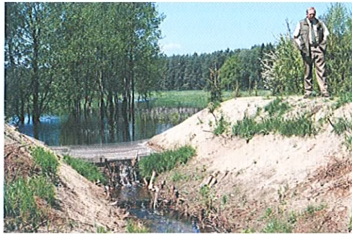
Różne typy zastawek na torfowisku na rowach melioracyjnych. Fot. R. Stańko.
