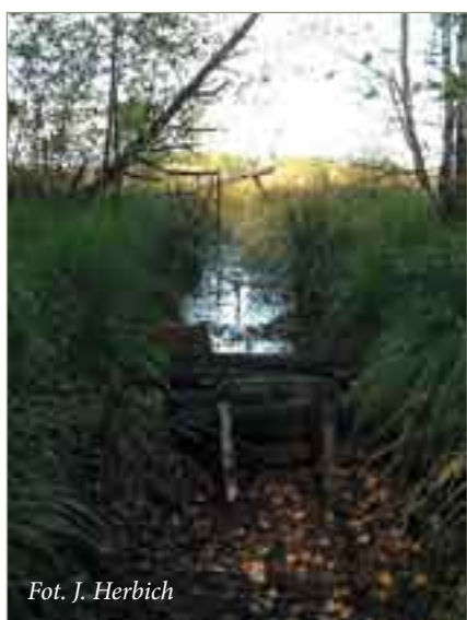
Fot. 59-66. Różne typy stałych przegród drewnianych wykonanych w ramach projektu. Various models of damming barriers used during the project.
