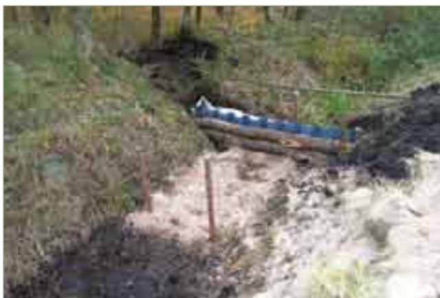
Fot. 67. Przegroda ze ścianką z tworzywa sztucznego - torfowisko „Olszanka”. Plastic damming barrier - „Olszanka” peatbog.
