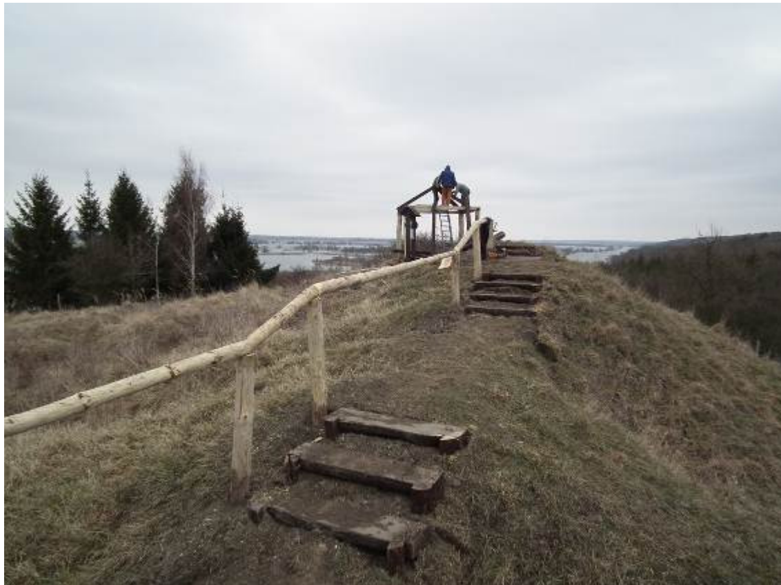
Budowa punktu widokowego w rezerwacie Słoneczne Wzgórza na terenie nadleśnictwa Chojna (fot. P. Pluciński)
