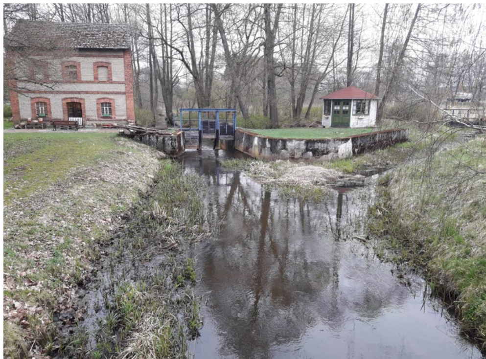
Fot. 7. Jaz Grzęda poniżej Starych Budkowic. Rozrząd wód pomiędzy stare koryto Budkowiczanki (w prawo) i Kanał Hutniczy (w lewo). Fot. P. Pawlaczyk
