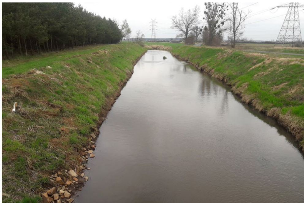
Fot. 71. Skrajnie uproszczone koryto koło Starych Kolni, permanentnie utrzymywane w złym stanie hydromorfologicznym przez powtarzalne prace utrzymaniowe. Fot. P. Pawlaczyk
