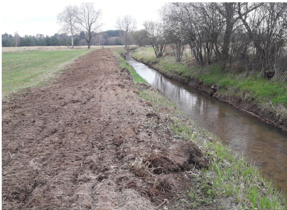
Fot. 56. Bogacica na zachód od mostu w Bukowie – niewłaściwie wykonane prace utrzymaniowe „usuwania roślin korzeniących się w dnie” (osady denne wydobyte, zdeponowane i częściowo rozplantowane na brzegu). Fot. P. Pawlaczyk
