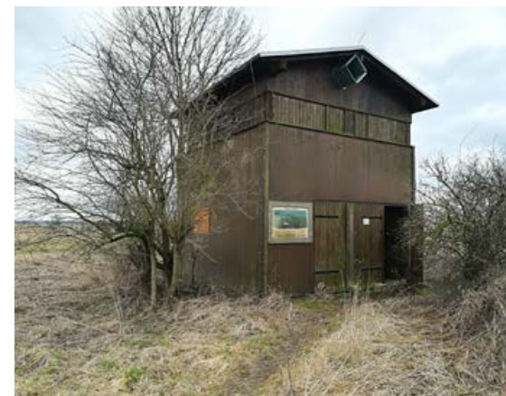
Wieża obserwacyjna. Fot. M. Maciantowicz.
