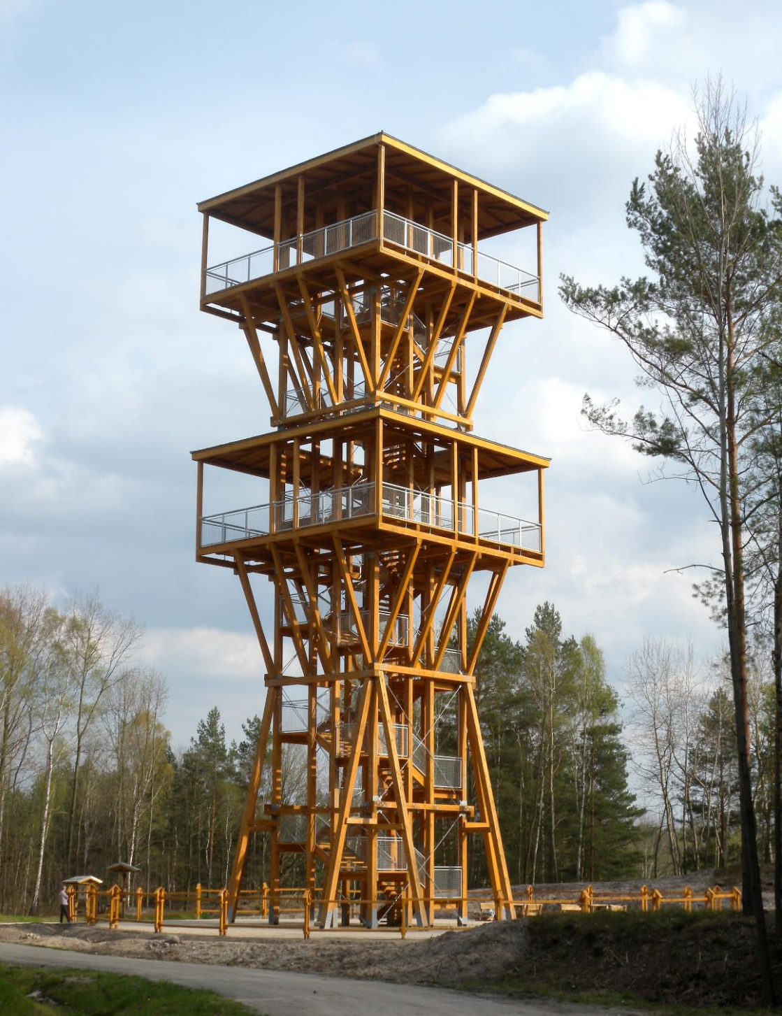
Wieża widokowa przy ścieżce geoturystycznej
