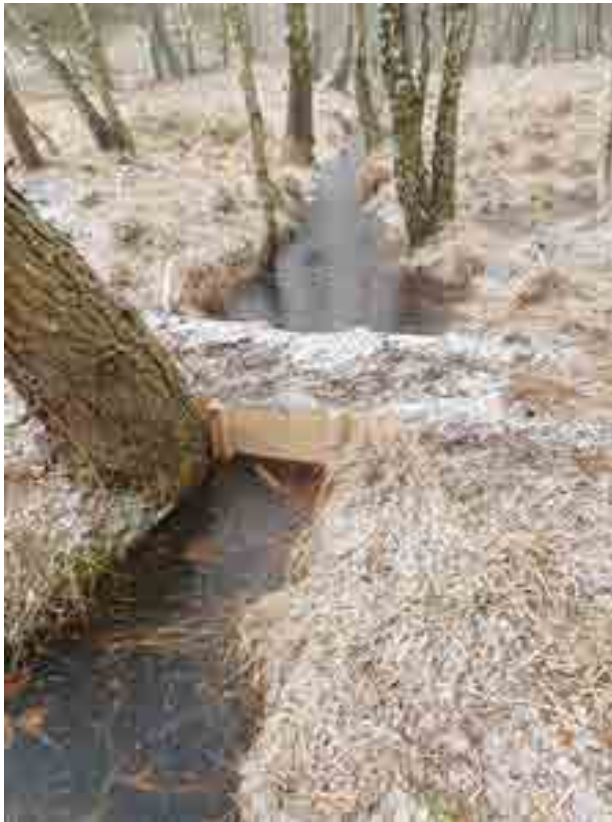
Fot. 5.1. Przykład wykonanego przetamowania ziemnego (zdj. W. Spychała)
