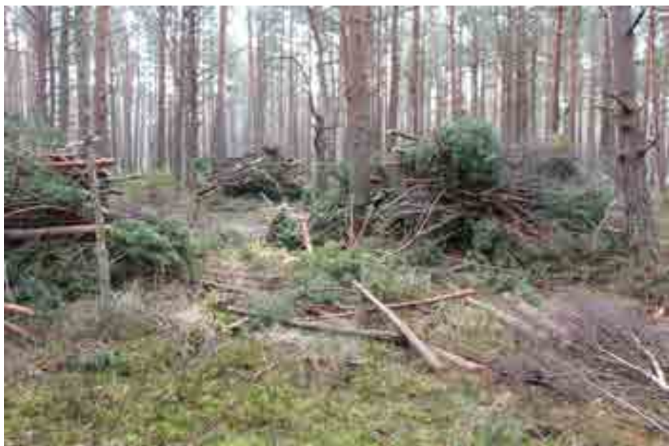
Fot. 5.3 Usuwanie drzew – prace w toku (zdj. K. Bociąg)
