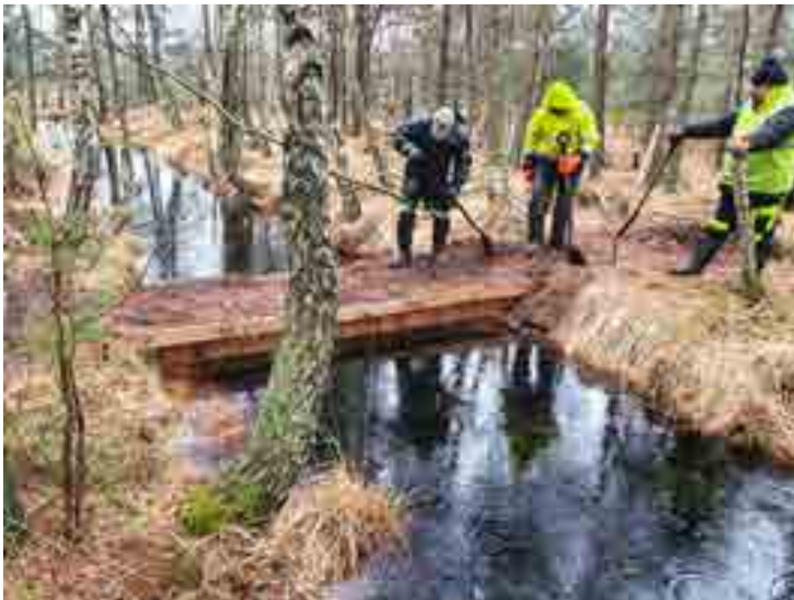
Fot. 5.2. Prace przy budowie przetamowania wzmocnionego (zdj. W. Spychała)
